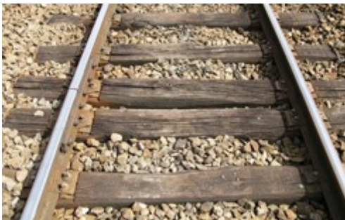
Rails courts sur traverses bois
